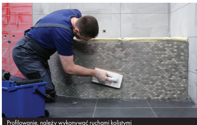
Profilowanie, należy wykonywać ruchami kołystymi
