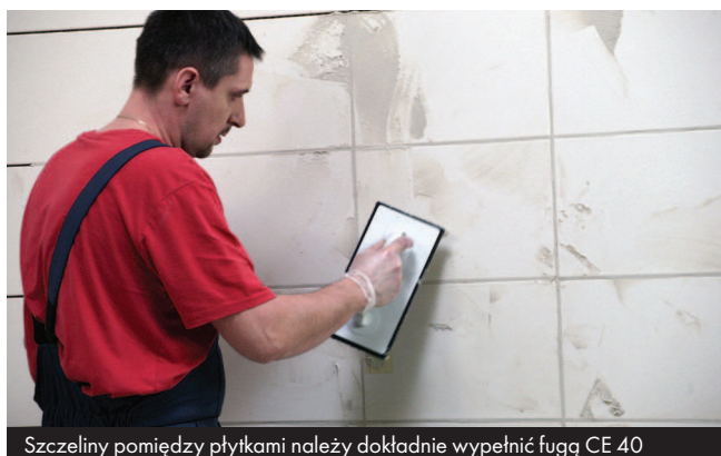
Szczeliny pomiędzy płytkami należy dokładnie wypełnić fugą CE 40
