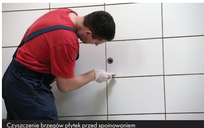
Czyszczenie brzegów płytek przed spoinowaniem
