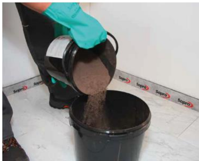
2 Dodać 2,5 kg Sopro DF 10® i wymieszać mechanicznie.
