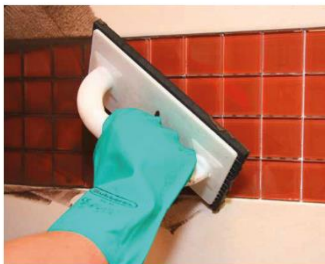
4 Spoinowanie mozaiki szklanej Design Fugą Flex Sopro DF 10® ze srebrnym brokatem Sopro.
