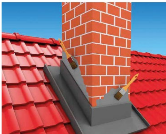
2 Niwelowanie nieszczelności przy obróbkach kominowych
