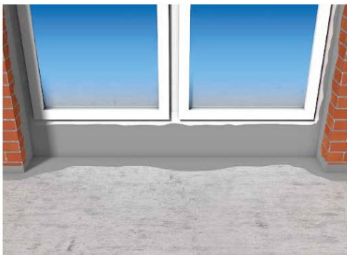
5 Uszczelnianie szczelin przy ościeżnicach okiennych i drzwiowych
