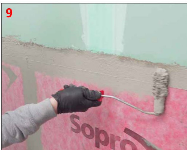
9 Krawcowe odcinki maty Sopro AEB® 640 obrobione również klejem wodoszczelnym Sopro FDK 415 lub zaprawą Sopro DSF RS 623.
