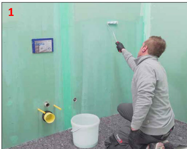
1 Podłoże chłonne zagruntować preparatem Sopro GD 749.
