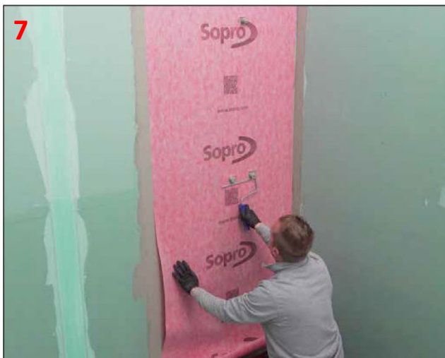
7 Przycięty na wymiar odcinek maty Sopro AEB® przyłożyć do świeżej warstwy kleju rozprowadzonego na podłożu, mocno docisnąć matę od środka do kierunku krawędzi.
