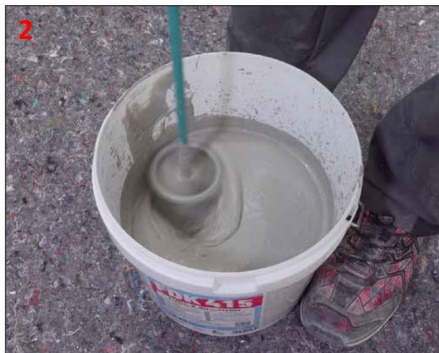
2 Sopro FDK 415: składnik płynny B wlać do czystego pojemnika i przy pomocy mieszarki wymieszać ze składnikiem proszkowym A, aż powstanie jednolita, bez grudek, masa. Alternatywnie: DSF RS 623 wymieszać z wodą w odpowiedniej proporcji.
