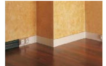
Instalacja w listwie z PVC
